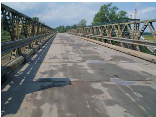
Původní stav mostu
