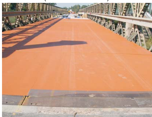
Penetrace antioxidačním nátěrem ZED S94
