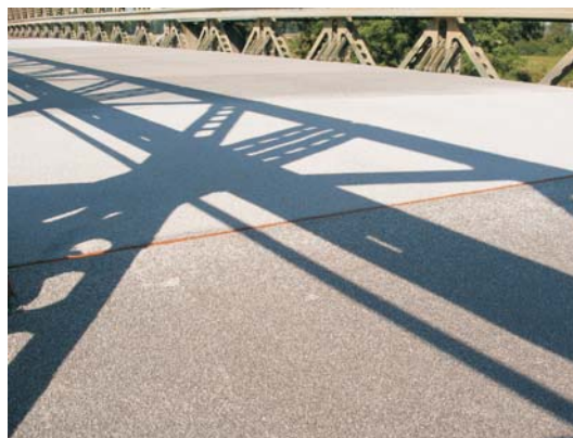
Stav po aplikaci utěšňujícího nátěru SEALER
