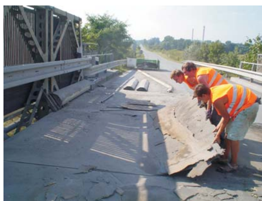
Odstranění původní hydroizolace ( PLASTBETONU )
