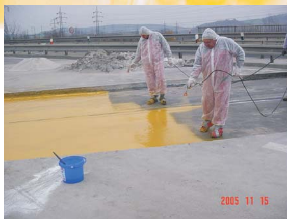
Aplikace první vrstvy ELIMINATOR®
