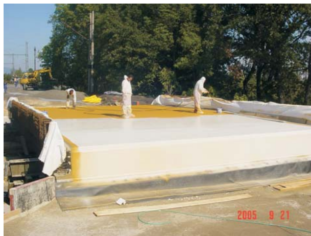
Aplikace druhé vrstvy hydroizolace ELIMINATOR® na betonový podklad
