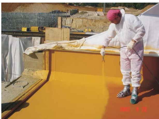
První vrstva hydroizolace ELIMINATOR®
