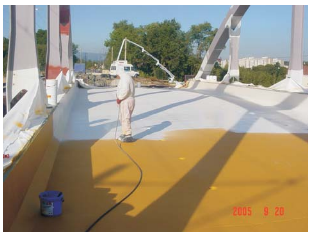
Aplikace druhé vrstvy hydroizolace ELIMINATOR® na ocelový podklad
