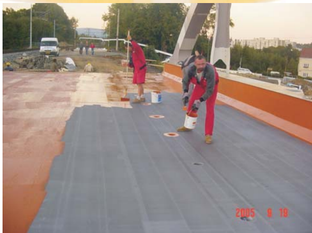
Aplikace penetračního nátěru ZED S 94
