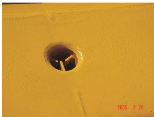
Řešení izolace odvodňovače na mostovce
