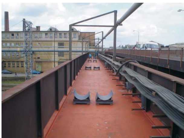
Osazení konzol po provedení penetrace
