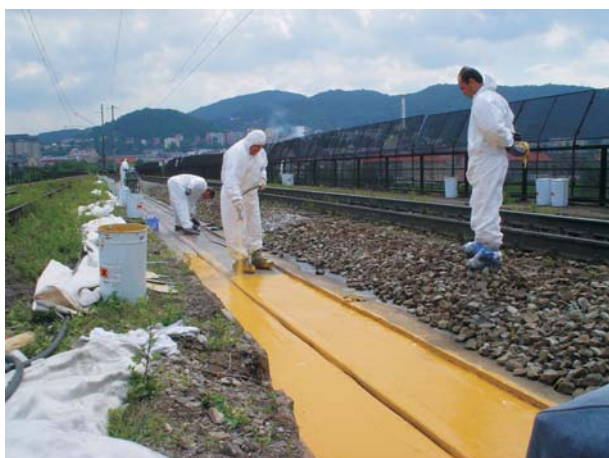
Aplikace první vrstvy ELIMINATOR®
