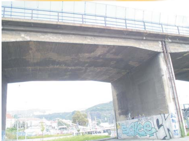
Pohled na spodní část mostu
