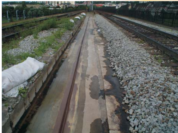
Vlepení PVC profilu
