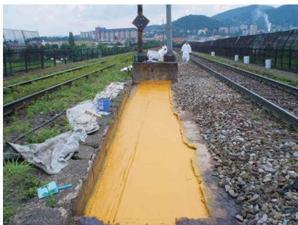
První vrstva systému ELIMINATOR®
