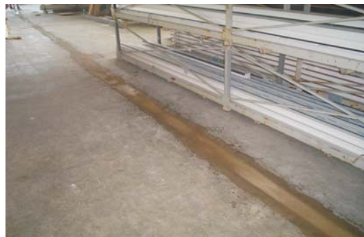
Pohled po realizaci
